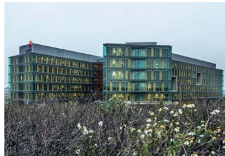
PriceWaterhouseCoopers, Gasperich, Luxemburg BREEAM Sehr Gut / Bauabnahme 2014 ETAP-Lösung mit U7 Einbauleuchten, R8 und R4 Anbauleuchten und E6 Leuchten mit hoher Schutzklasse
