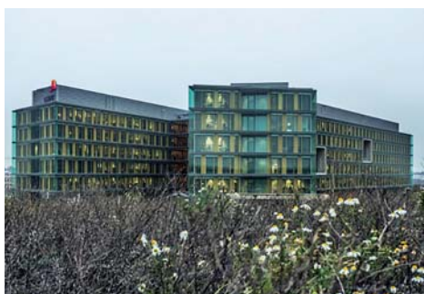
Hoofdzetel PriceWaterhouseCoopers, Gasperich, Luxemburg BREEAM Very Good / Oplevering 2014 ETAP-oplossing met UT1 inbouwarmaturen, R8 en R4 opbouwarmaturen en E6 industriële armaturen.
