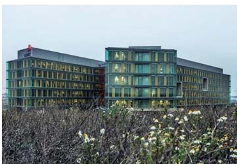
PriceWaterhouseCoopers, Gasperich, Luxemburg BREEAM Sehr gut / Bauabnahme 2014 ETAP-Lösung mit UT1 Einbauleuchten, R8 und R4 Anbauleuchten und E6 Leuchten mit hoher Schutzklasse
