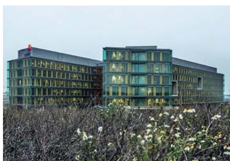
PriceWaterhouseCoopers, Gasperich, Luxembourg BREEAM Very Good / Réception 2014 Solution ETAP avec luminaires à encastrer UT1, luminaires en saillie R8 et R4 et luminaires à facteur de protection élevé E6
